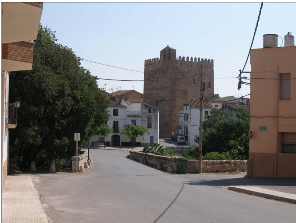
Fotografia 1: Pont de la carretera vella de Tortosa a la Galera. Al fons, Sant Llorenç.
