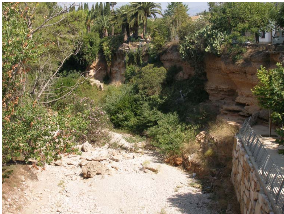
Fotografia 4: Talús de la riba esquerra del barranc de la Galera, aigües amunt del pont de la carretera vella de Tortosa a la Galera. S'observen morfologies d'erosió al talús.
