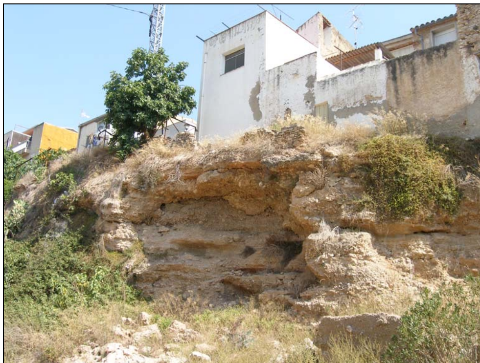
Fotografia 6: Zona del talús de la riba esquerra del barranc de la Galera, afectada per despreniments, sota un immoble del carrer Carasol (punt a del plànol 4).
