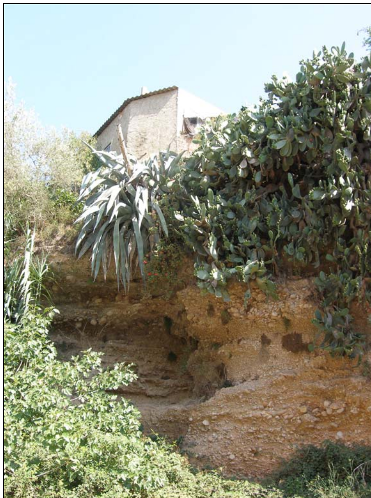
Fotografia 5: Balma situada al talús de la riba esquerra del barranc de la Galera, aigües avall del pont de la carretera vella, en una àrea adjacent a un immoble del carrer Soledat.
