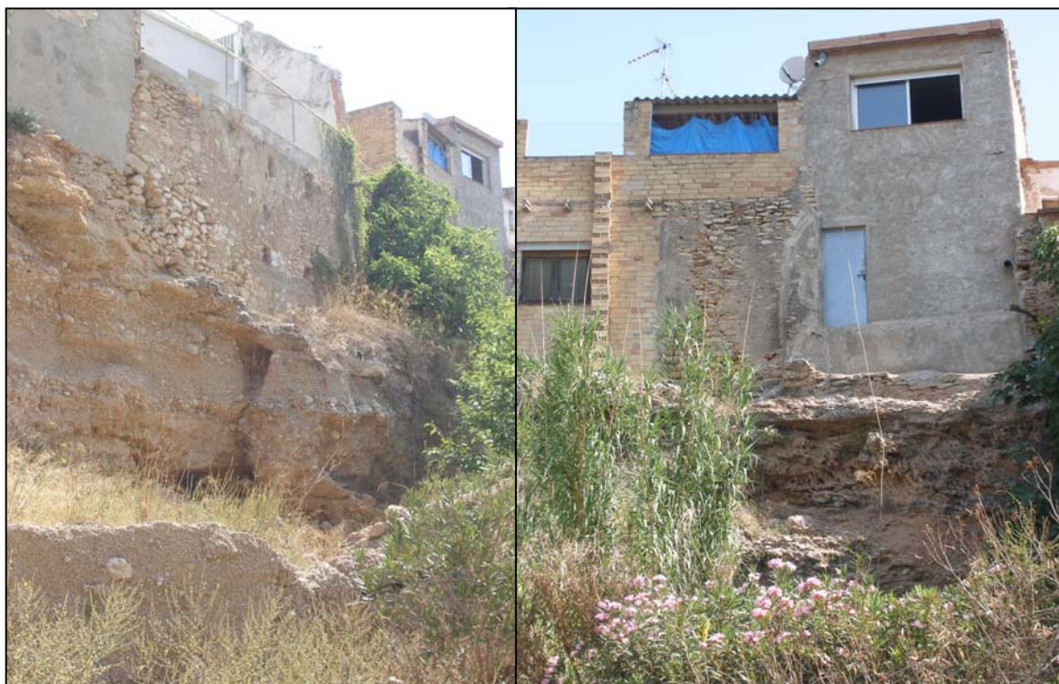
Fotografies 8 i 9: Immobles del carrer Carasol situats al límit superior del talús del barranc.
