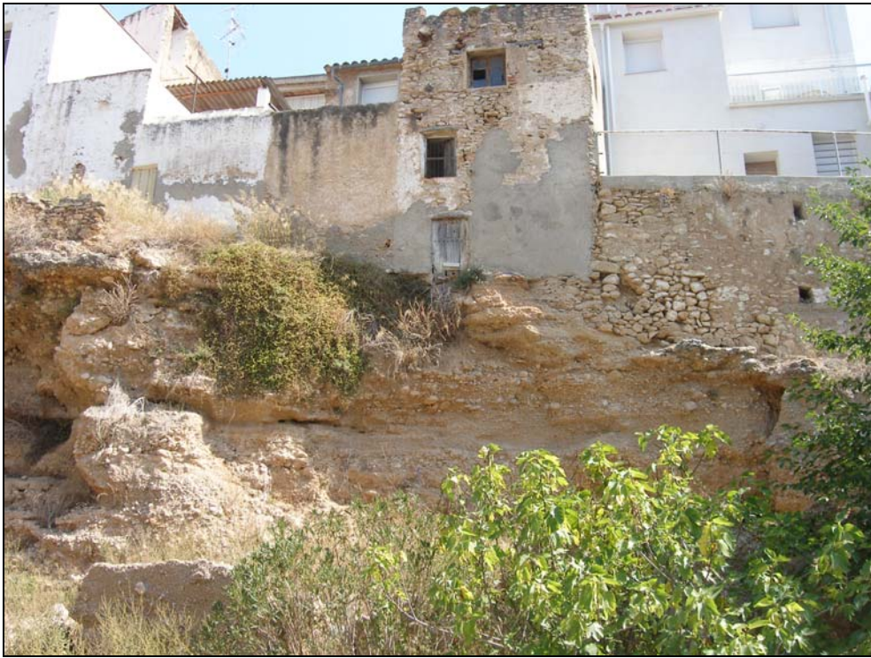
Fotografia 10: Zona del talús de la riba esquerra del barranc de la Galera, afectada per desprendiments (punt c del plànol 4).
